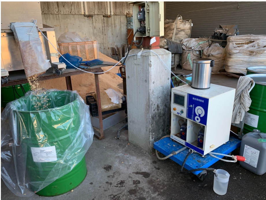
写真 2. 定量供給ポンプを用いたギ酸添加
