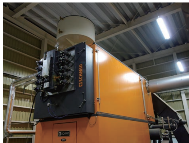
写真2 木質チップ（左）と木質チップ専用の温湯ボイラー（右）
