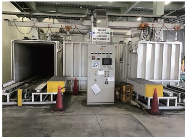
写真8 真空予冷施設
