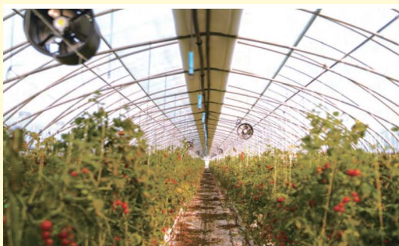
コラム一写真2 保温カーテンや流動・換気ファンが設置されたハウス (出典：スマートファームコリア)
