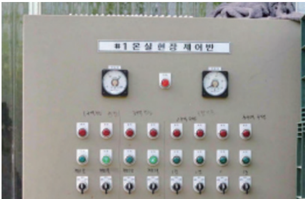
写真11 温室環境コントロールパネル (出典：スマートファームコリア)
