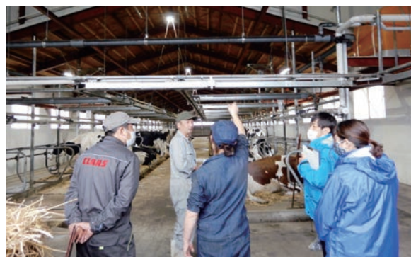
写真2 B農場の牛舎 (頭が当たらない高さにレイアウトされた配管)
