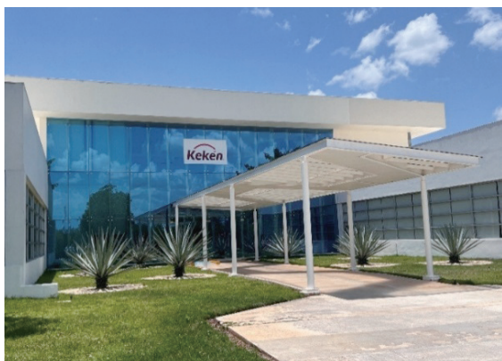
写真8 設備を近代化し再建されたSahé工場
