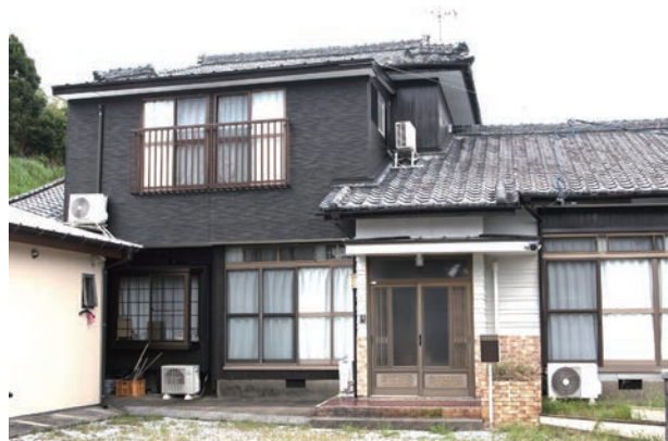
写真7 寮として利用するため購入してリフォームした一戸建て
