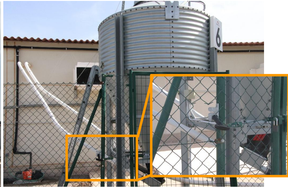
養豚場を囲む二重柵(左)と柵外から開閉可能な飼料タンク(右)
