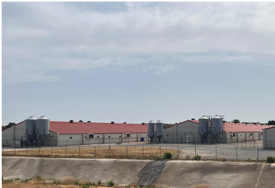
養豚場を囲む二重柵(左)と柵外から開閉可能な飼料タンク(右)
