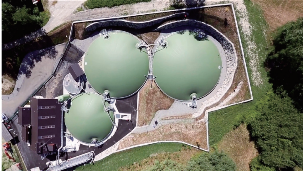
写真3 パッケージ型バイオガスシステム「SMART-D」 写真は牛約 2000 頭規模（1日当たり処理量 160 トン）のプラント
