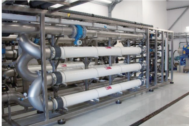
写真5 消化液濃縮・バイオ液肥製造システム「D-UF+RO」
