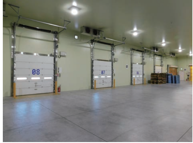
写真5 2号棟のドックシェルタータイプの出庫口
