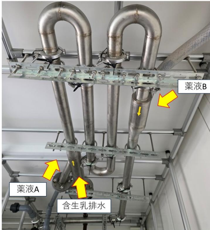
写真1 三方ジョイントの構成
