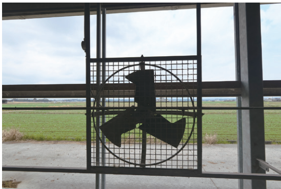
写真9 搾乳牛舎の換気扇 自然風により多数の換気扇が稼働し、空気循環が図られている。
