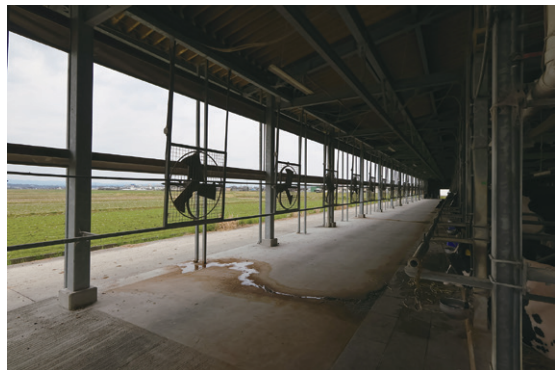
写真9 搾乳牛舎の換気扇 自然風により多数の換気扇が稼働し、空気循環が図られている。
