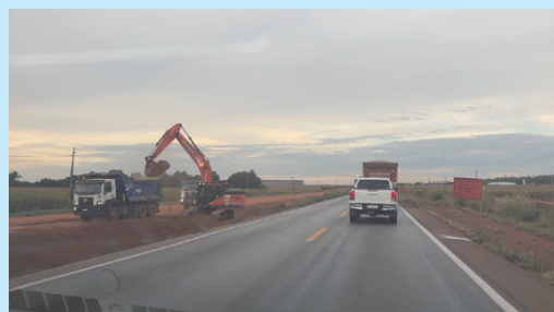
コラム2－写真 国道163号線の片側1車線区間における工事の様子
