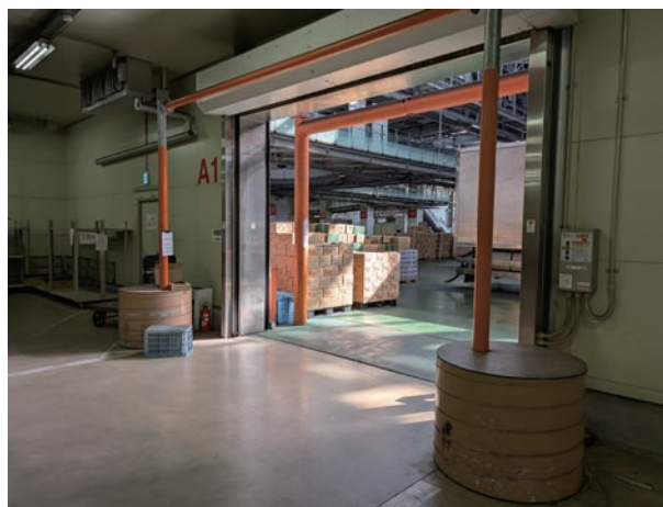
写真3 定温卸売場のシートシャッターの門型ガード (左：外側、右：内側)
