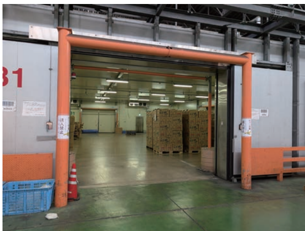
写真3 定温卸売場のシートシャッターの門型ガード (左：外側、右：内側)
